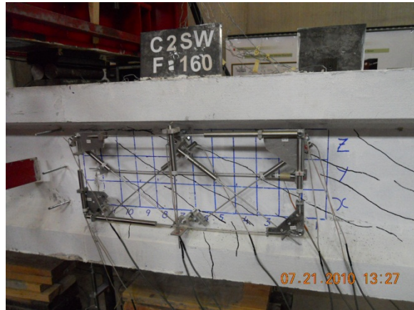
(d) Shear crack pattern before failure
