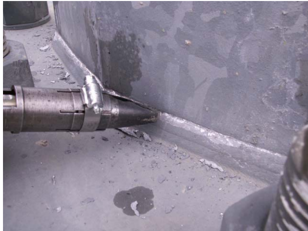
(a) UIT in progress
