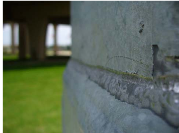
(b) Typical residual groove after UIT
