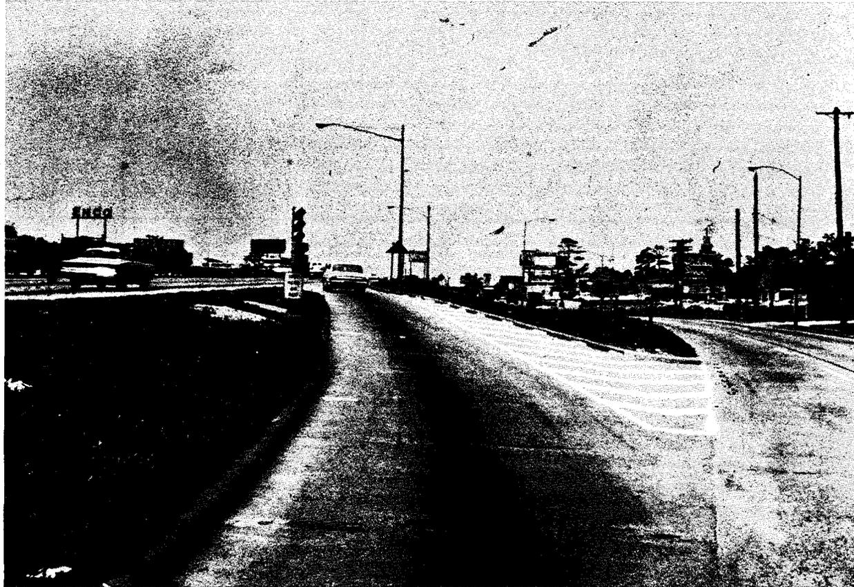
FIGURE 27 – SHORT SIGHT DISTANCE OF DOWNSTREAM FREEWAY TRAFFIC EXIST AT SEVERAL ENTRANCE RAMPS AS SHOWN AT THE GRIGGS RAMP
